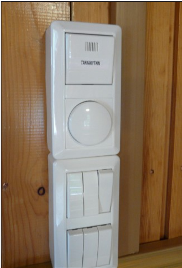
Tuvassa on ovenpielessä takkakytkin, jolla saadaan ilmastointi pois päältä takan tai lieden sytytyksen ajaksi.
