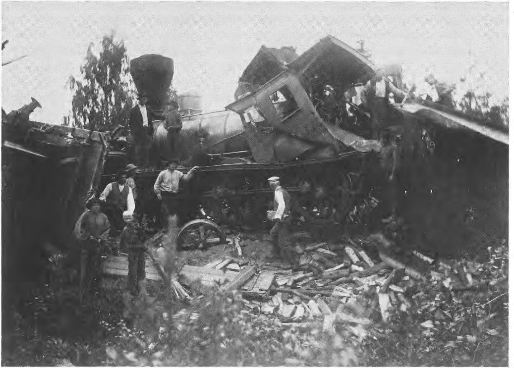
Inkeröisissä vuonna 1905 sattuneen junien yhteentörmäyksen jälkiä. Onnettomuudessa sai surmansa kuljettaja A. Koponen, joka todennäköisesti olisi voinut pelastautua hyppäämällä veturista ennen törmäystä, mutta yritti sen sijaan loppuun asti lieventää yhteenajon voimaa. Onnettomuuden jälkeen Kuljettaja- ja lämmittäjäyhdistyksessä pohdittiin vakavasti kysymystä siitä, mitkä olivat veturimiehen velvollisuudet tällaisessa tilanteessa. Rautatiemuseo.
